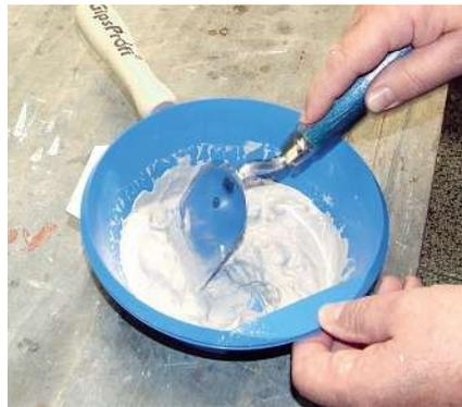
**Bild 5a:** Zunächst wird ein wenig Gips angerührt...
